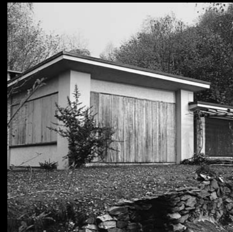
Monti di San Nazzaro. Villino urbano costruito al posto di una stalla-fienile.
