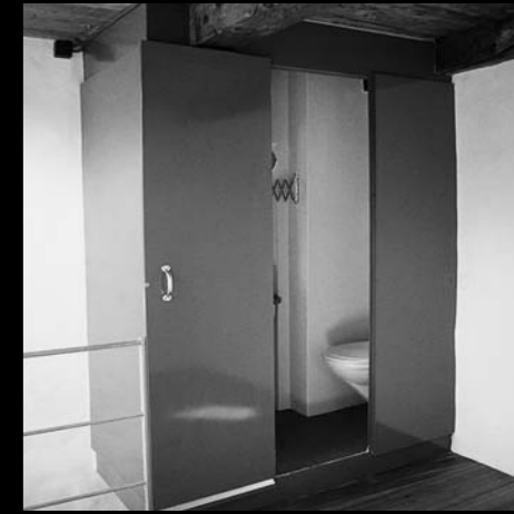
Cerentino. La concentrazione dei servizi igienici (doccia, lavandino e WC) in un armadio permette al piccolissimo locale di accogliere ancora un letto francese.
