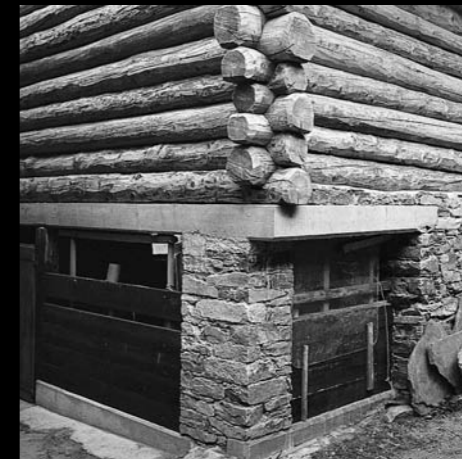
Dandrio in Val Malvagia. La dimora di legno preesistente è stata ricostruita utilizzando al posto delle travi squadrate dei tronchi scortecciati sovradimensionati.
