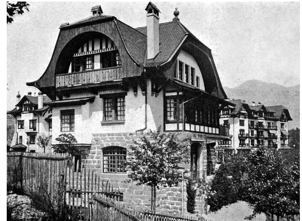
L'ensemble locatif de Bellaria à La Tour-de-Peilz, par Burnat & Nicati.
