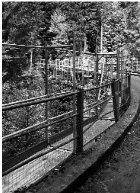
Geländer an der Schwandbachbrücke (1933) von Robert Maillart: Die Horizontalen bestehen aus Wasserrohren, die Vertikalen sind aus Doppel-T-Profilen gefertigt. Der untere Teil der Geländer wurde später mit Maschendrahtgeflecht gefüllt.
