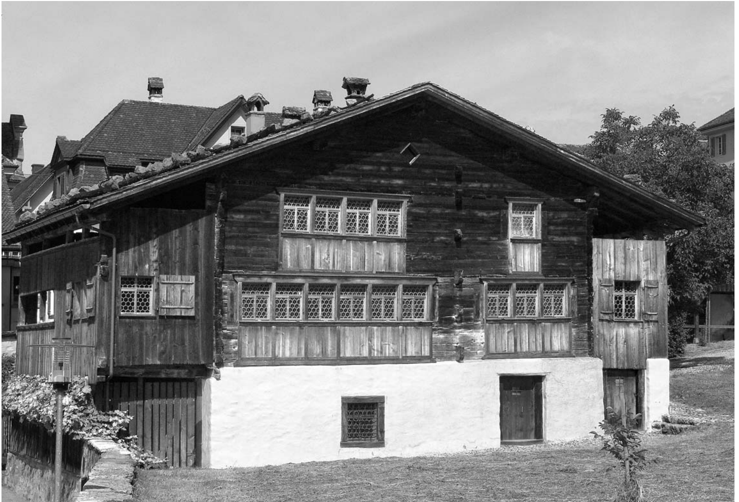
Schwyz, Haus Bethlehem, um 1287 errichtet. Die Fensteröffnungen mit Zugladeneinrichtungen sowie die verschalten Lauben stammen aus dem 18. Jahrhundert.
