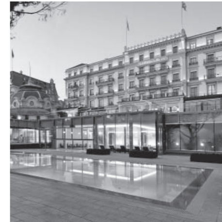
Lausanne-Duchy, Hôtel Beau-Rivage-Palace: Als Hôtel Beau-Rivage am Seeufer von Ouchy 1861 neu erbaut, 1908 erweitert mit dem neuen, höheren Gebäudeteil Palace.
