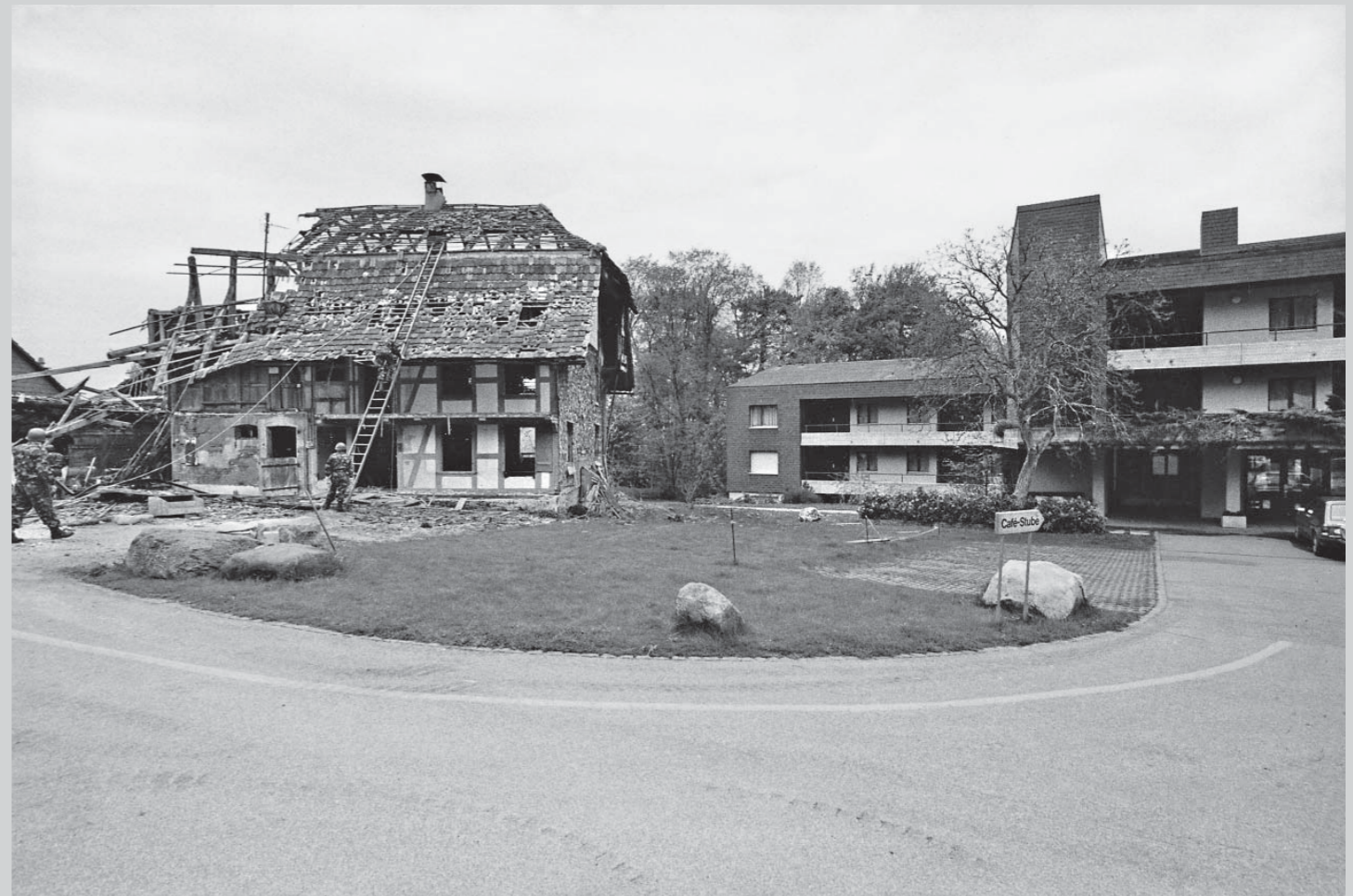
Abbruch eines Bauernhauses neben dem Altersheim in Ins.
