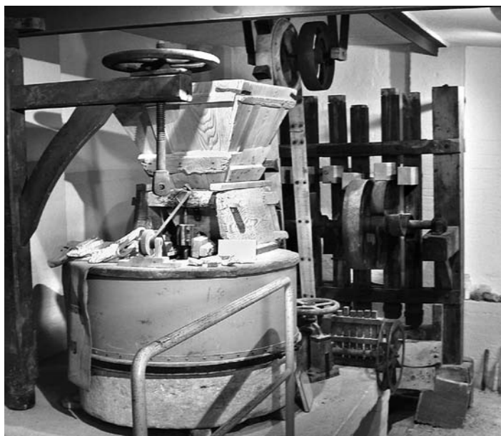
Beispiele einer Gipsmühle (links) und einer Gipsstampe im Museum.
