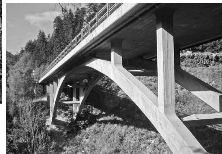
Alexandre Sarrasin: Pont sur le Laxgraben, Lax (1941–1942).
