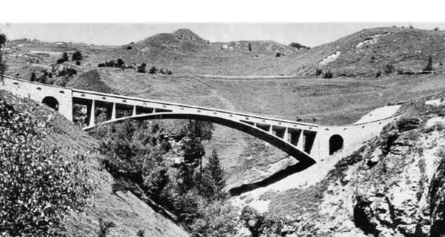
Robert Maillart: Pont du Val Tschiel (1925).
