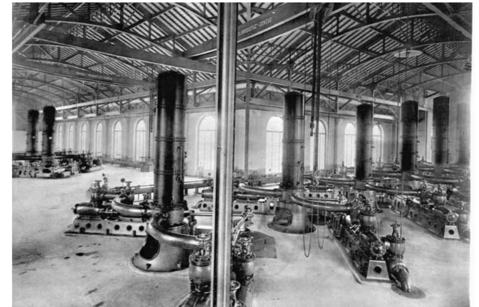
Pompes de la centrale à eau sous pression de la Coulouvrenière.
