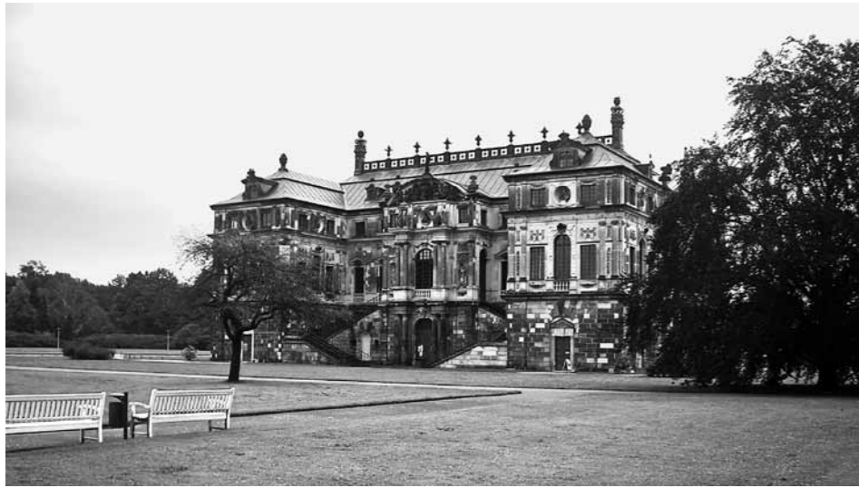
In seinem zerbrechlichen Zustand denkmalwürdig: Palais im Grossen Garten Dresden.
