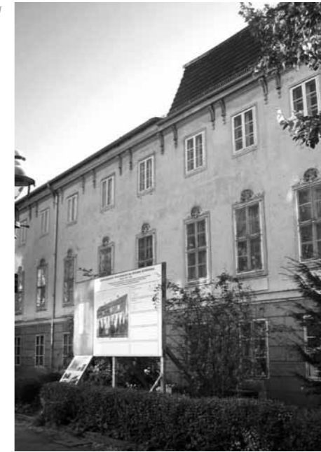
Das «Schoeler-Schlösschen» in Berlin: Gut zu erkennen ist der fehlende Teil des Daches.
