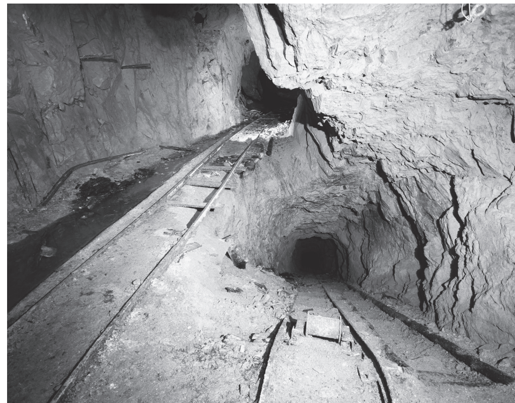
Blei-Zink-Mine Goppenstein (VS): Tiebelstollen und schräger Förderschacht, um 1900.
