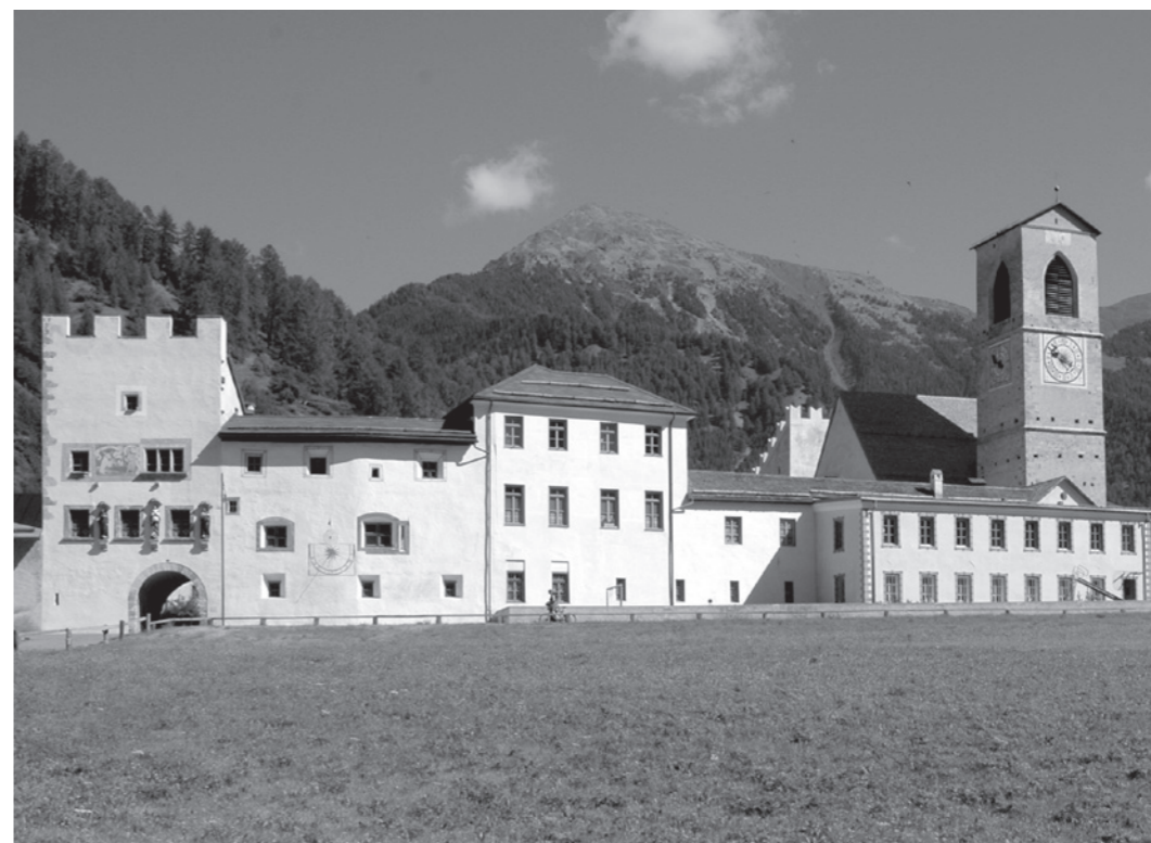
Das Kloster ist gleichzeitig Lebensraum der Benediktinerinnen, Restaurierungsobjekt, archäologische Forschungsstätte und Unesco-Welterbe. Dank der Bauhütte können alle Ansprüche und Interessen koordiniert werden.
