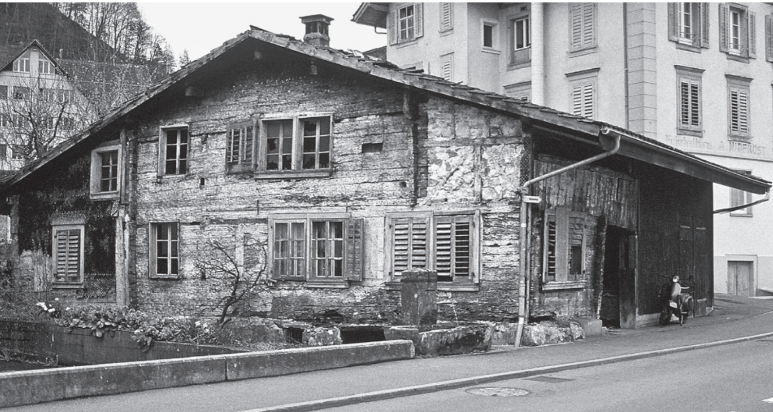
Haus Nideröst an seinem ehemaligen Standort in Schwyz. Kernbau von 1176 mit jüngeren Anbauten und Rückwand aus wiederverwendetem Bauholz von 1270.
