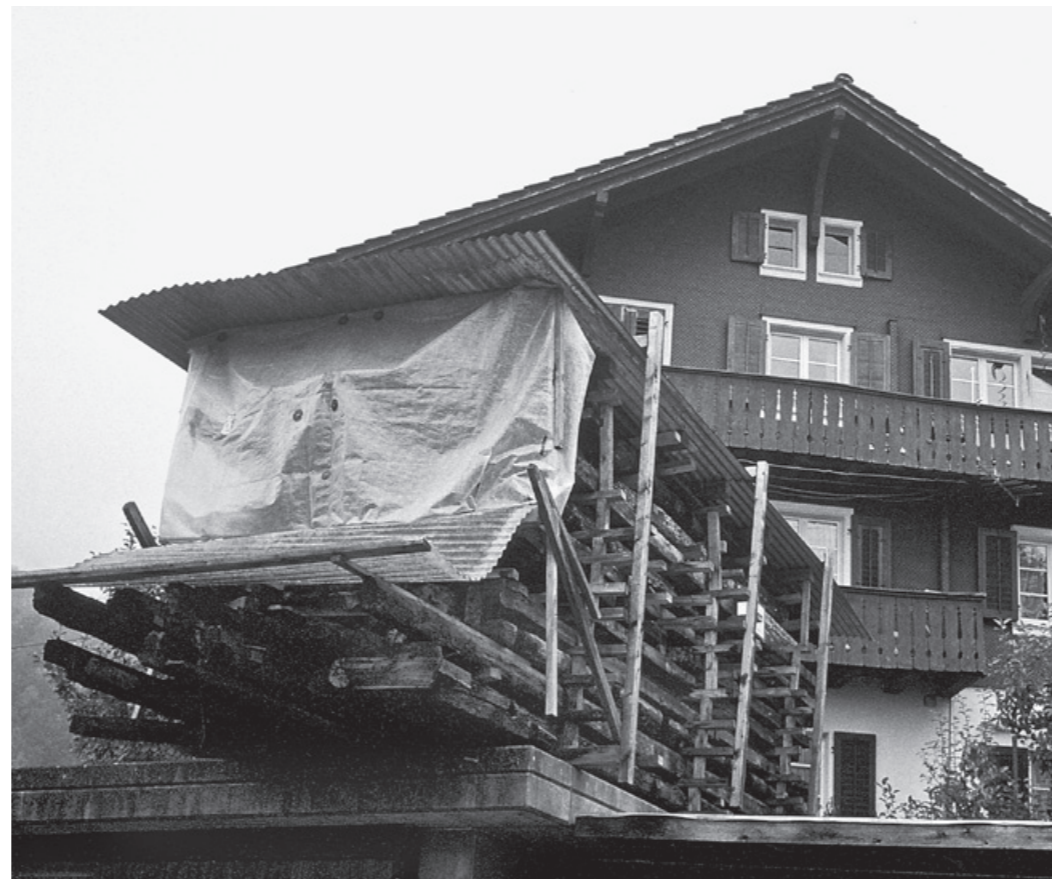
Dasselbe Haus gestapelt und zwischengelagert.
