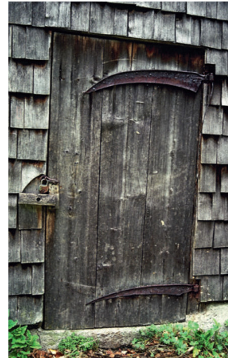
Sensenblätter als Türbeschläge verwendet. Heustall in Silenen (UR), Fryental.
