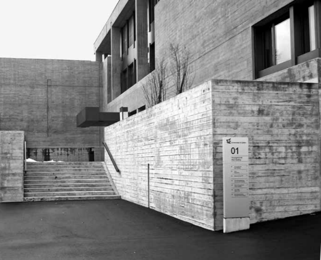
Bei der Universität St. Gallen erfolgte die Betonsanierung nach dem Grundsatz «So wenig wie notwendig».
