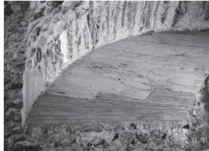
*Ramosch (GR), Burgruine Tschanüff. Untersicht des ausgeschalteten Unterfangungsgewölbes. Unten das gestufte Widerlager aus Beton.*
