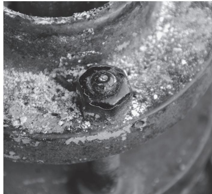
Verwitterung und Farbschichten machen das Lösen von Schrauben zu einer heiklen Angelegenheit.
