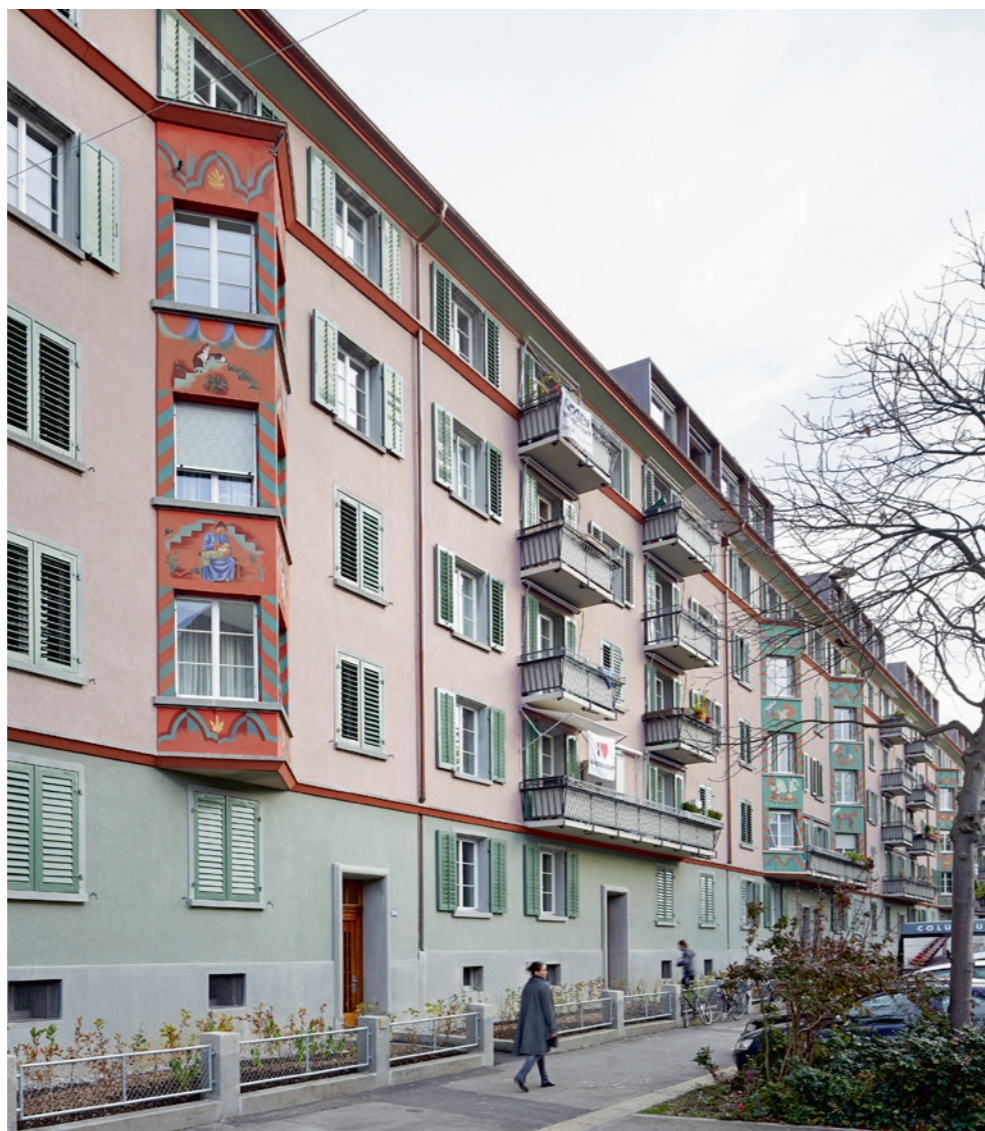
Sihlfeld: Die denkmalgeschützte Gebäudestruktur und Aussenfassade.
