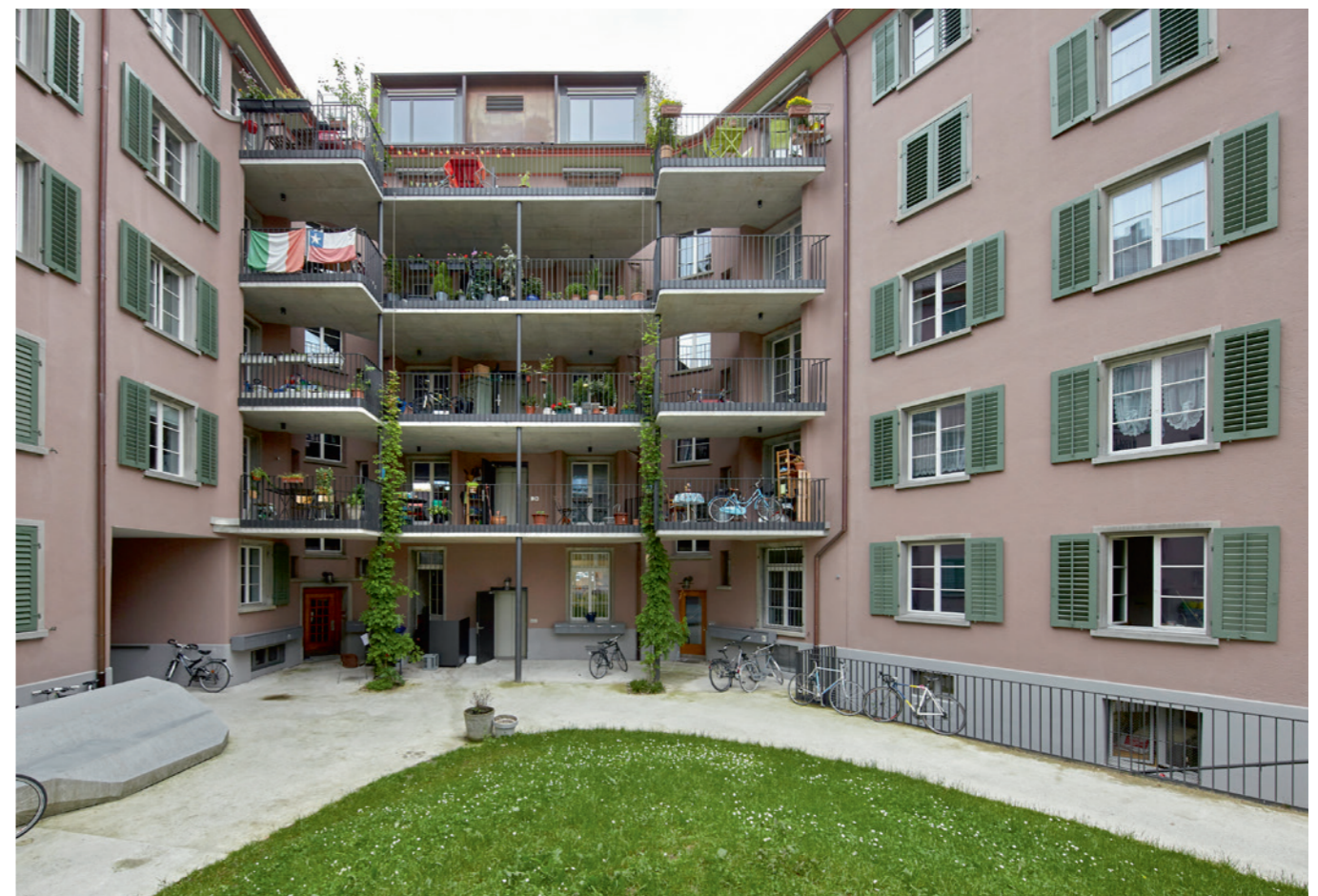
Sihlfeld: Innenhof mit neuen Balkonen und Dachaufbau.
