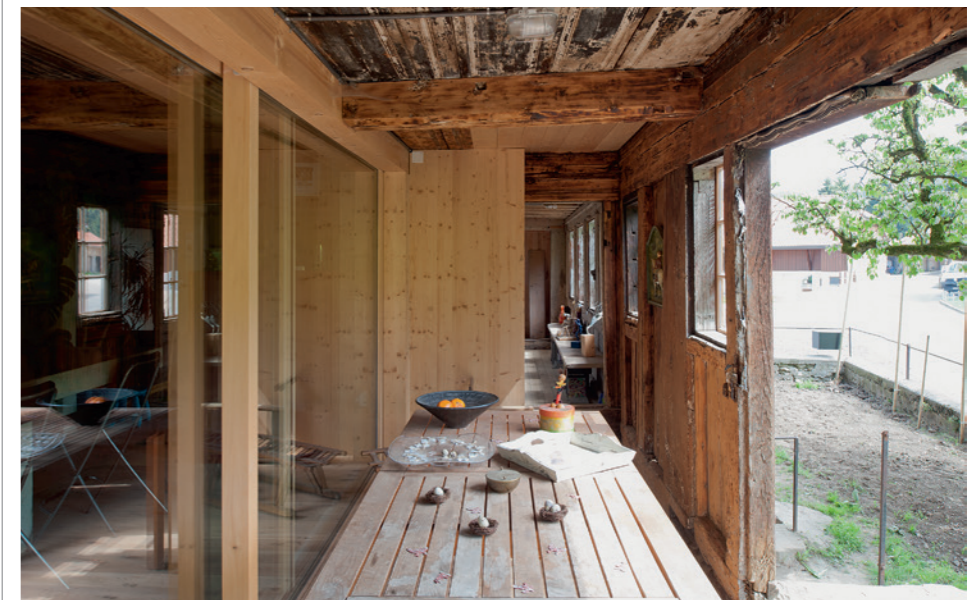
Fig. 4: Le retrait des volumes par rapport aux façades existantes dans une ferme transformée à Montécu permet l'amenée de lumière, une isolation thermique performante en conservant le caractère des façades. Il génère des espaces interstitiels de qualités, ouverts à diverses utilisations.
