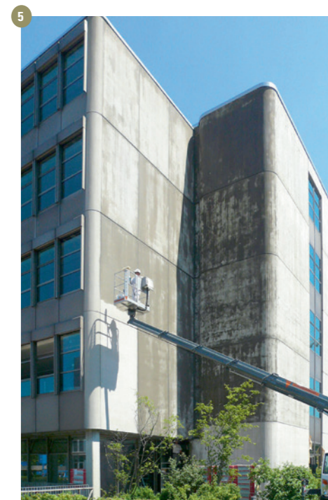
Abb. 5: Lenzburg, Hauptgebäude der Berufsschule: Reinigung der Sichtbetonfassade, 2015.
