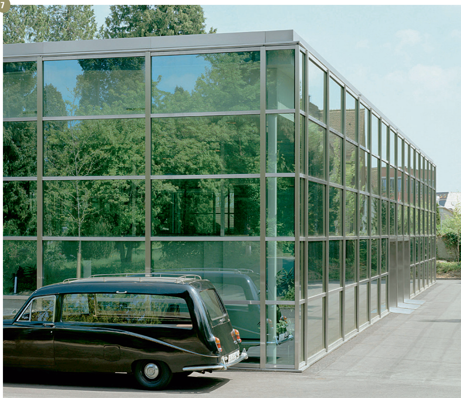
Abb. 7: Aarau, Neue Abdankungshalle, Alfons Barth und Hans Zaugg, 1968. Zustand nach der 2007–2008 von Husistein & Partner AG durchgeführten Sanierung.
