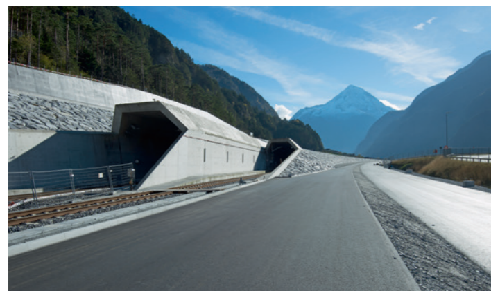
Abb. 6: NEAT-Portal: Auch die neue Architektur setzt Massstäbe. Foto von Christof Hirtler, 2013
