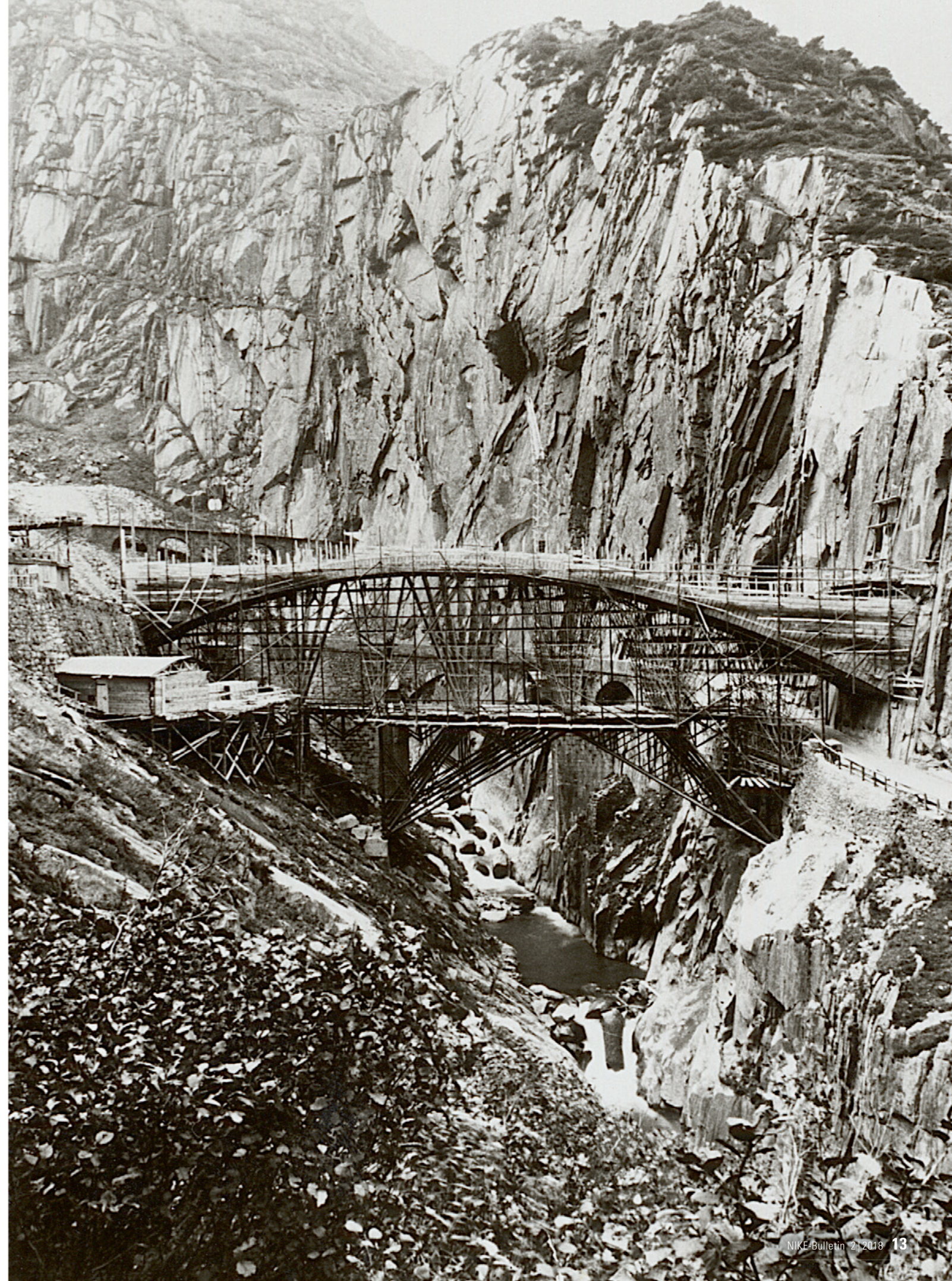
Abb. 1: Lehrgerüst der neuen Teufelsbrücke. Im Hintergrund die Konstruktion von 1830. Die erste Teufelsbrücke stürzte 1888 ein. Foto 1957.
