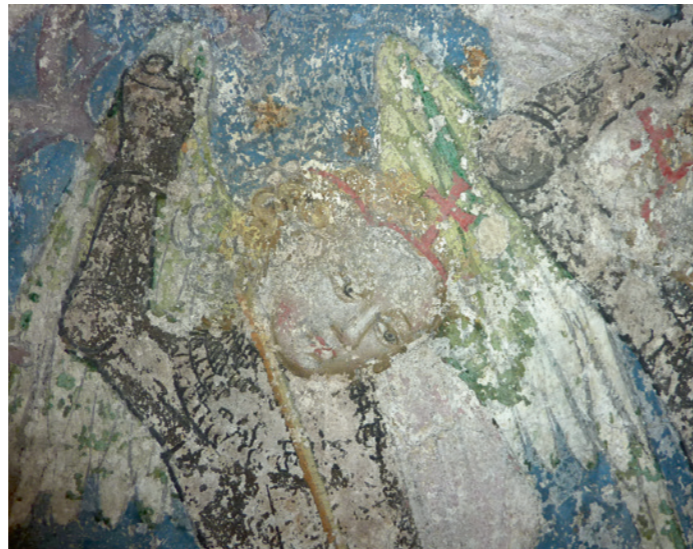
▲ Wandmalerei im Münster Konstanz: Neben dem Ausbleichen führt auch der Substanzverlust zu einer Reduktion der ursprünglichen Wirkung. Bei Wandmalereien sind oft nur noch die Vorzeichnungen und Untermalungen erhalten. Trotzdem sind sie für uns lesbar und ein wichtiges Zeugnis.
