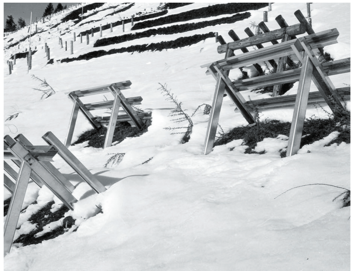
Abb. 5: Versuchsbau, der 1951 vom SLF auf dem Dorfberg (GR) erstellt wurde. Stützverbauungen sind der wichtigste bauliche Lawinenschutz in der Schweiz: Mehr als 500 km Stützwerke verhindern das Anbrechen von Lawinen und prägen so die alpine Landschaft massgeblich.
