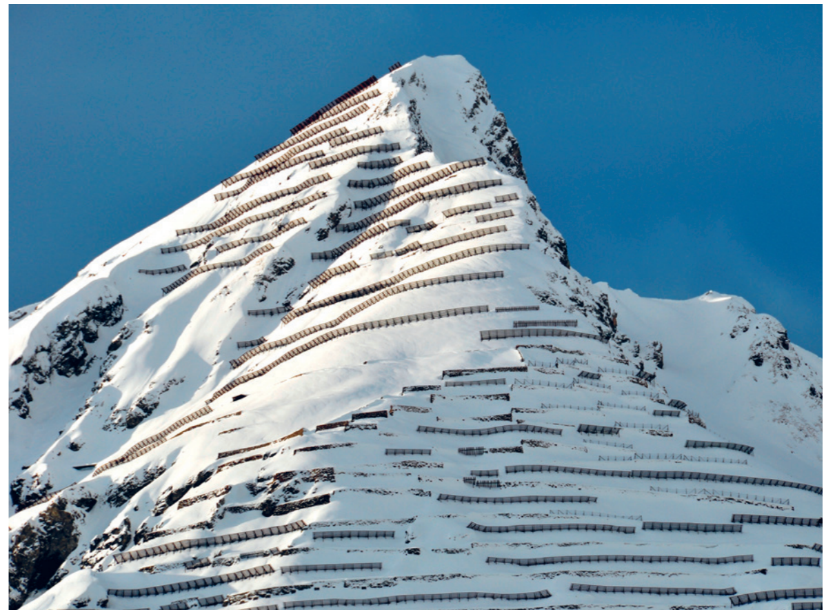
Abb. 4: Landschaftsprägend: Im Lawinenanrissgebiet am Schiahorn oberhalb Davos (GR) stehen insgesamt rund 10 km Stützwerke und Mauern. Die ersten Mauern wurden 1920 aus Steinen erstellt, die neusten Stützwerke aus Stahl können eine bis zu 5 Meter hohe Schneedecke stabilisieren und diese am Anbrechen hindern.
