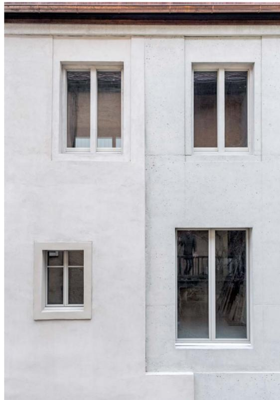
Verzahnung von Mauerwerk und Sichtbeton an der Seitenfassade.
