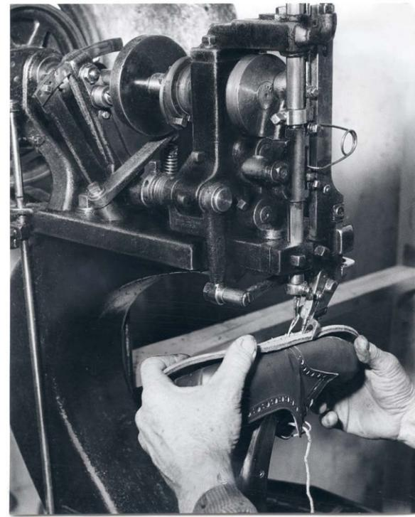
**Abb. 4 und 5:** Mensch und Maschine. Je nach Modell waren für die Herstellung eines Schuhs 100 bis 200 Arbeitsschritte nötig. Für fast jeden Schritt gab es eine Maschine und eine Fachkraft für die Bedienung. Jedes Werkstück wurde einzeln bearbeitet.
