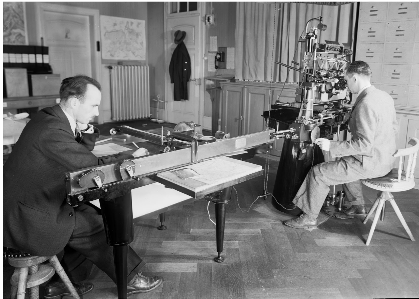
Ingenieure der Landestopografie bei der Arbeit am Stereoautografen Wild No. 3, 1938. © Swisstopo, Bildsammlung, Inv. 000-398-991
