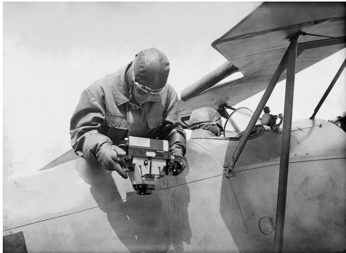
Handhabung der Fliegerkamera Wild, ca. 1930. Die luftbildbasierte Landesvermessung bedeutete eine Zeitenwende in der Kartenproduktion. © Swisstopo, Bildsammlung, Inv. 000-398-822
