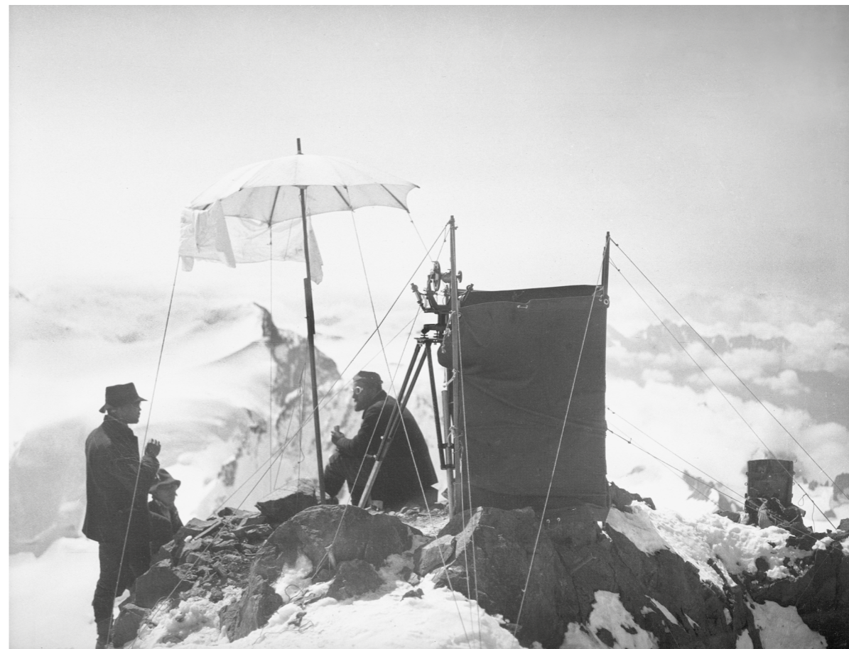
Vermessungsingenieure ganz oben: Signalstelle Piz Bernina, Versicherungsarbeiten und Instrumentenaufstellung, 1914. © Swisstopo, Bildsammlung, Inv. 000-402-566
