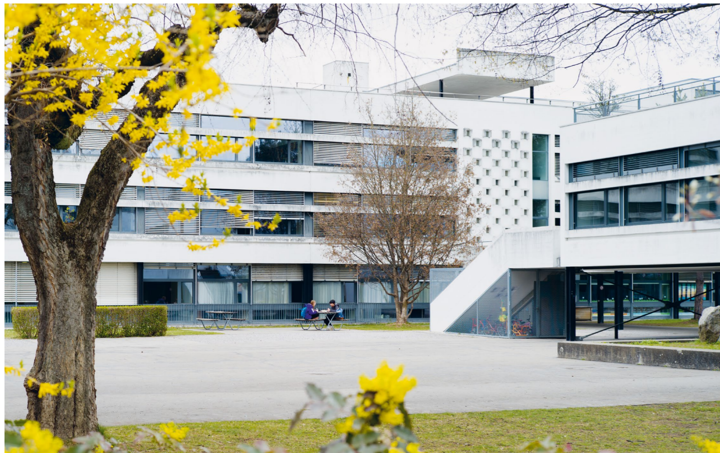
Klassentrakt und Treppenturm des 1959–1961 erstellten Schulhauses Wankdorf in Bern. Beim Entwurf orientierten sich die Architekten Marcel Mäder und Karl Brüggenmann an Bauten von Le Corbusier. © NIKE, Daniel Bernet
