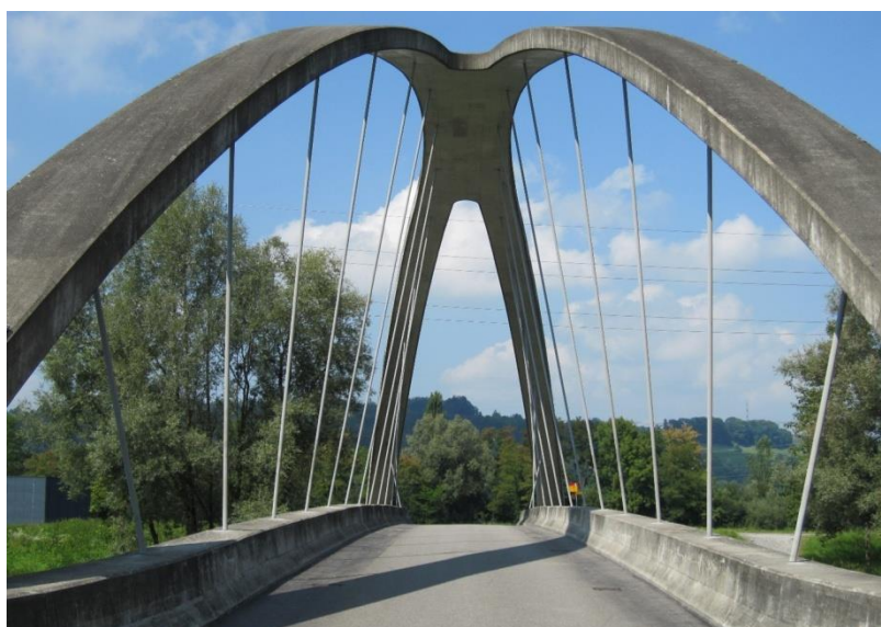
Les édifices construits dans des matériaux modernes tels que le béton font aussi partie du patrimoine culturel. Crédit : Jürg Conzett
